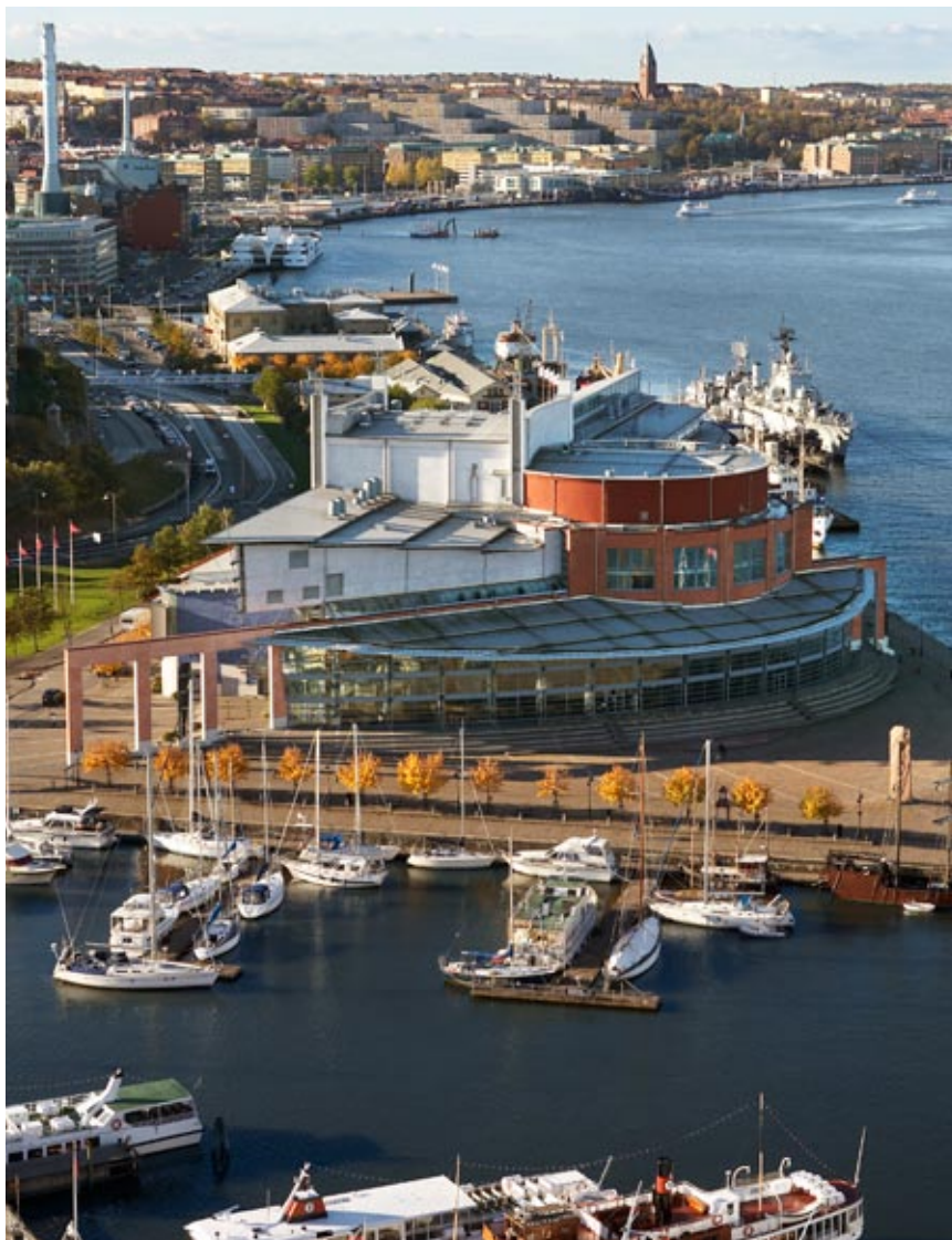
Operahuset i Göteborg fick en bandtäckning av Plannja Planplåt i blank aluminium.
