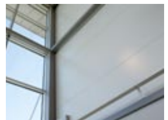
Plannja Panel 1200T. Väliseinä Nordbyn ostoskeskuksessa, Strömstadissa. Sinne valittiin vaakaan asennettu kirkkaanvalkoinen Plannja Panel 1200T.
