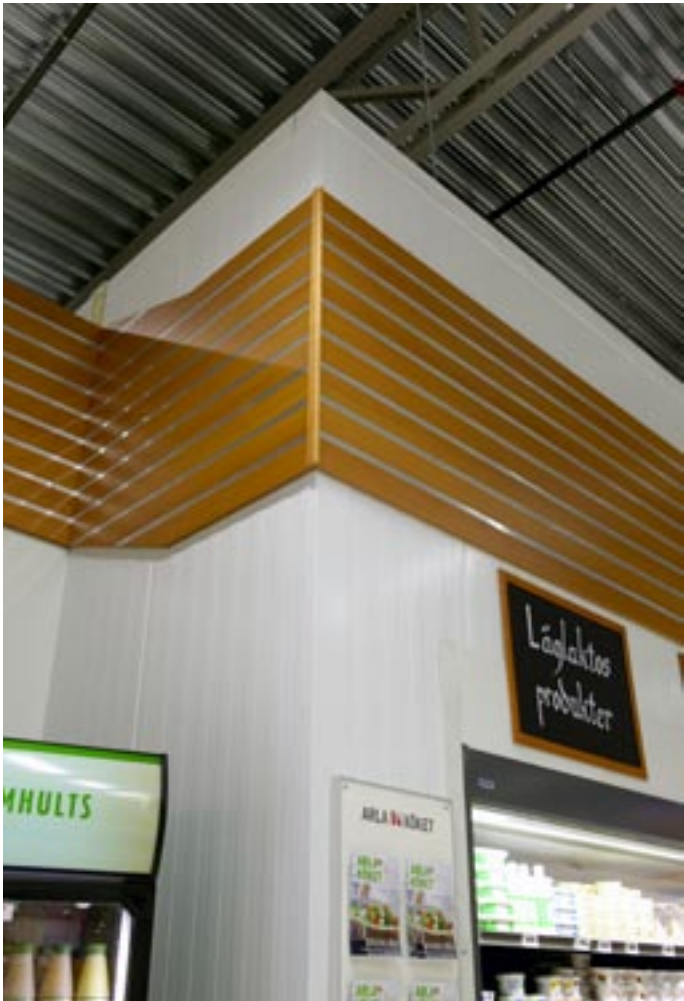
Plannja Panel 100. Väliseinä Nordbyn ostoskeskuksessa, Strömstadissa. Kirkkaanvalkoinen Plannja Panel 100 pystyasennuksena.
