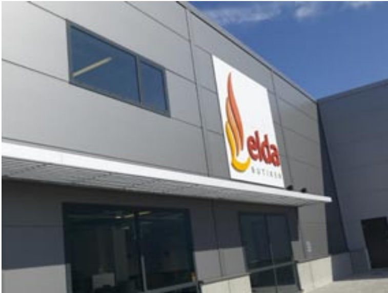
Plannja Panel 1200. Helsingborgissa sijaitseva Spismiljö och Eldabutiken. Plannja Panel 1200 tummanharmaana ja hopeametallin värisenä. Pilasterit sisäpuolisesti kiinnityksin ja SAPA-ikkunajärjestelmät tekivät Plannjan kokonaisratkaisusta täydellisen.
