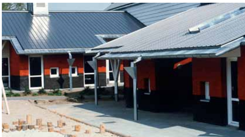
Tradition. Plåtslageriarbete av klass med bandtäckning och takavvattning som ger byggnaden ett tidsenligt utseende.
