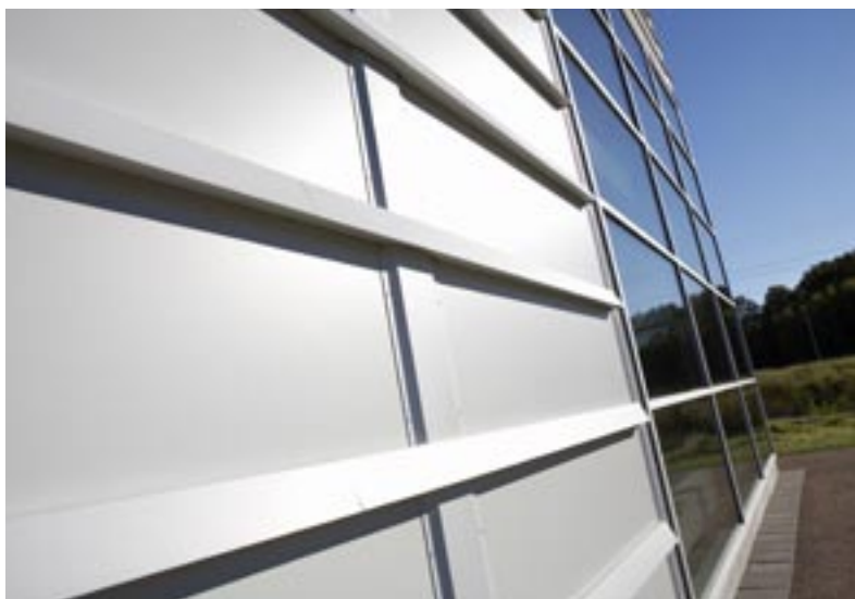
Den horisontalt løpende dekorlisten fra Plannja gir en markert skyggeeffekt. Monteres på hel skinne for størst mulig stabilitet.
