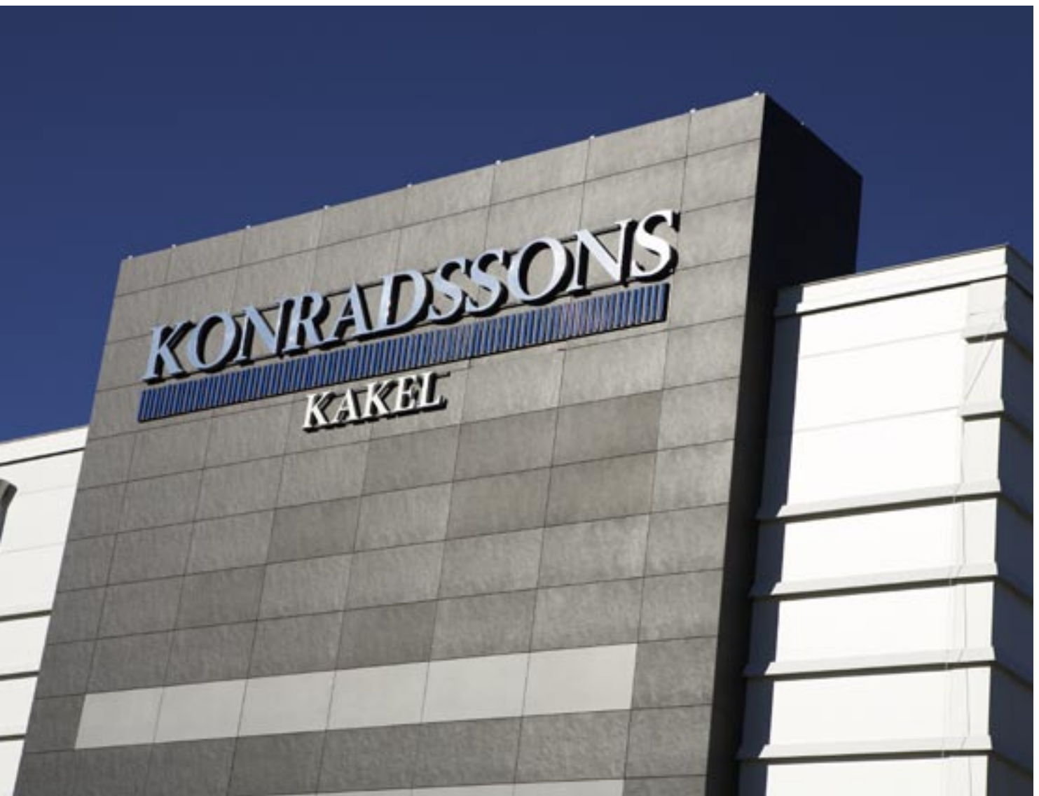
Plannja Panel 600. Konradssons Kakel i Mölndal fikk 1000 m 2 yttervegger av liggende hvit Plannja Panel 600. Den horisontale løpende dekorlisten fra Plannja ble montert på hel skinne for størst mulig stabilitet. Arkitekt: Arkitektbyrå AB Leif Bergelin. Byggherre: Skanska Sverige AB Region hus Göteborg.
