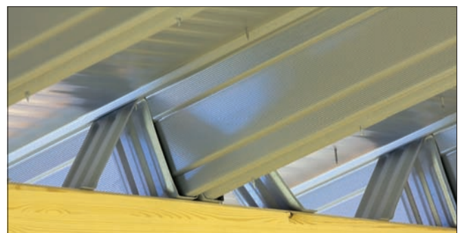
Lähikuva P200-profiilista asennustuen kohdalta
