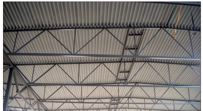
Kuvassa P111-profiilia asennusvaiheessa
